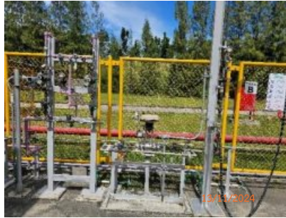
รูปที่ 3-61 อุปกรณ์ป้องกันก๊าซไหลกลับในท่อ (Check Valve)
